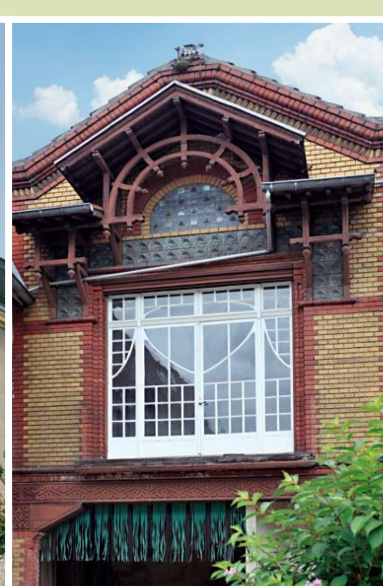
FONTOY, maison 12 rue de Metz, détail de la façade Art nouveau
